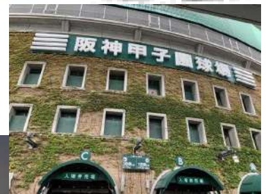
KOBE HANSHIN 兵庫県
