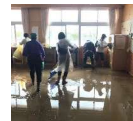
浸水した教室の清掃
